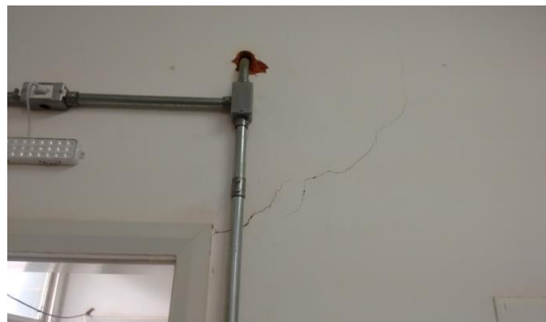
Figura 02 – Trincas na alvenaria
