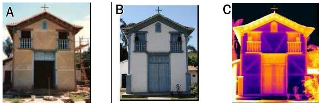
Figura 3. Fig. 3A: Fotografia da fachada da Capela de São Sebastião de Águas Claras em 1986, antes da intervenção. Fonte: MENEZES (1986 apud CORTIZO, 2007); Fig. 3B: Fotografia da fachada da Capela de São Sebastião de Águas Claras em 2007, após a intervenção; Fig. 3C: Fotografia Termográfica da fachada da Capela de São Sebastião de Águas Claras em 2007, após a intervenção, evidenciando os elementos ocultos da alvenaria. Fonte: CORTIZO, 2007.
