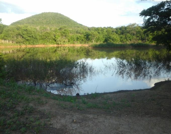
Foto 2 - Barragem de contenção de água/ área coletiva
