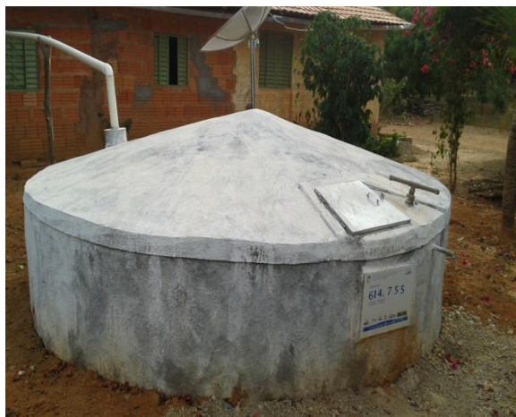
Foto1 -Cisterna de captação de água da chuva
