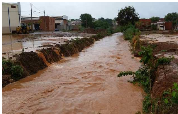
Figura 02: Alagamento em Montes Claros – MG em 2014 devido à falta de um sistema de drenagem eficiente.
